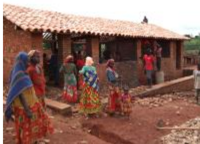
Fra bygging av slaktehuset
